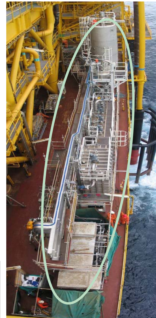
Блок закачки полимера на плавучей платформе на м/р Далия
